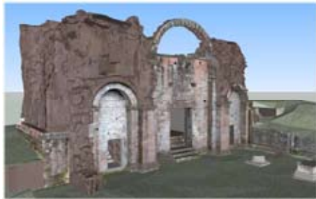
Fig. 1 : vue Est du Massif Occidental de l'église abbatiale.
